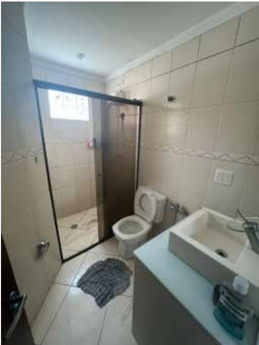
FOTO 18 Aspecto do banheiro.
