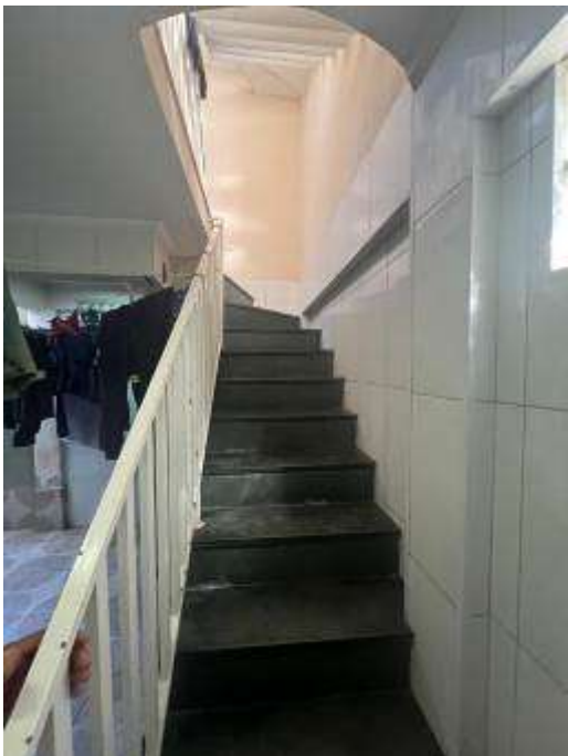
FOTO 11 Escada para o piso superior.
