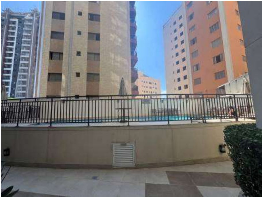
FOTO 09 Vista da piscina.
