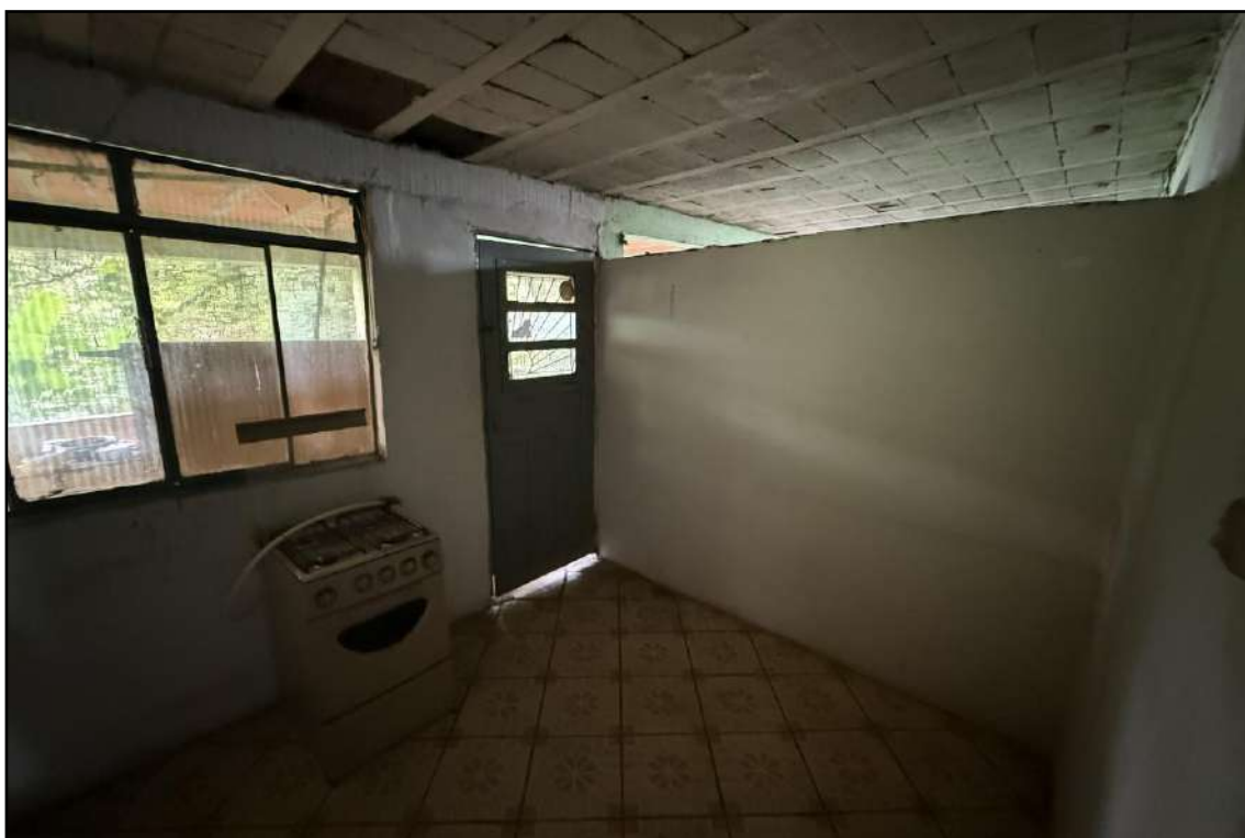
Figura 13 – Vista interna da “casa subsolo” objeto deste Laudo Pericial.
