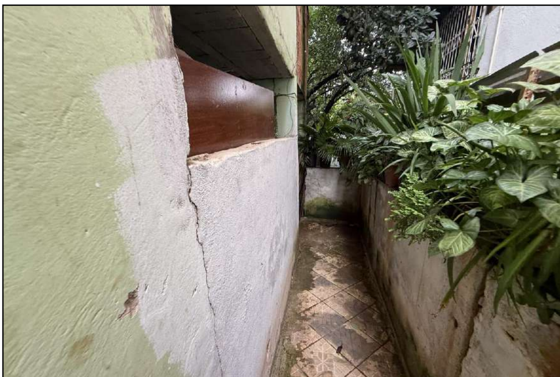
Figura 7 – Vista externa do imóvel objeto deste Laudo Pericial.
