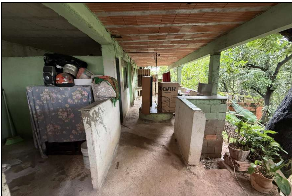
Figura 8 – Vista externa da “casa subsolo” objeto deste Laudo Pericial.
