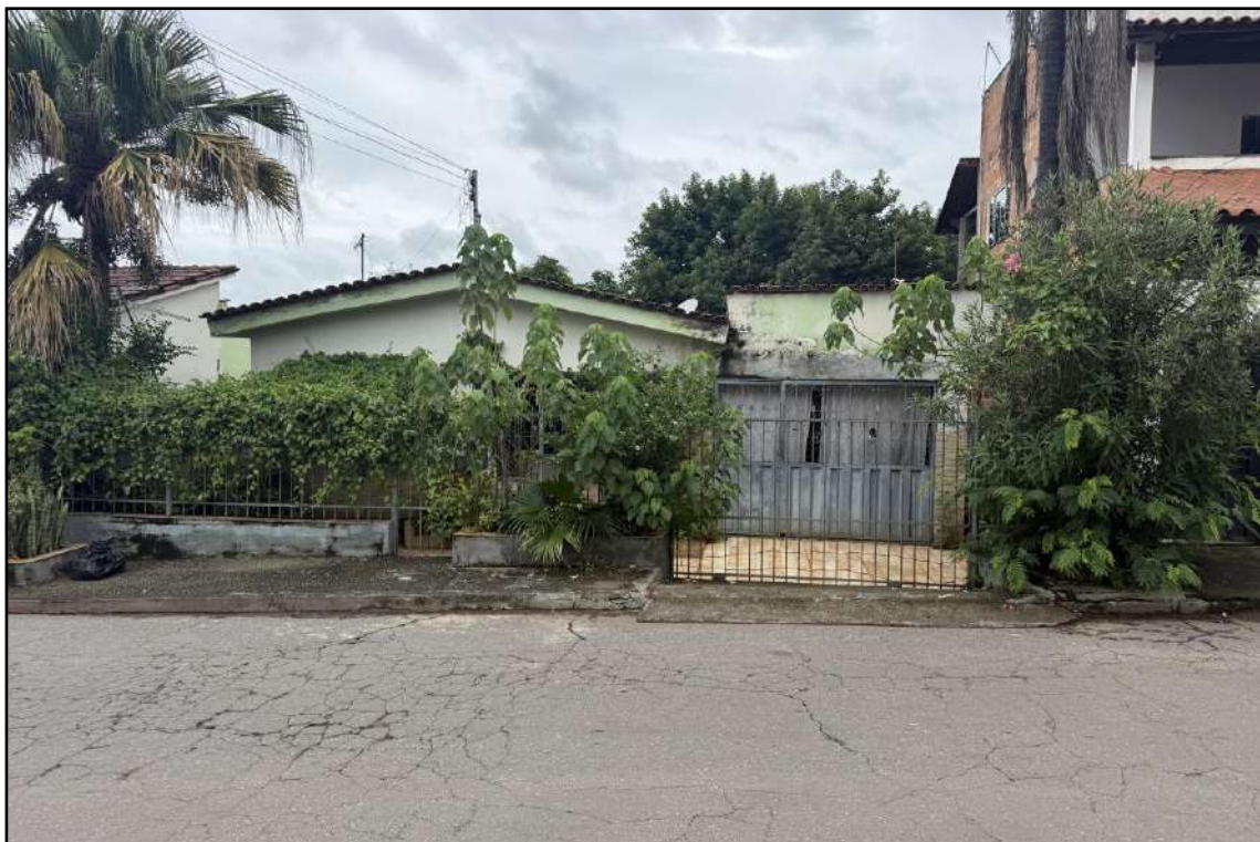
Figura 1 – Fachada do imóvel objeto deste Laudo Pericial.
