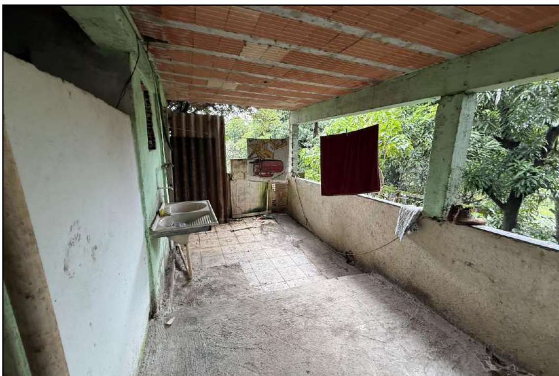
Figura 17 – Vista externa da “casa subsolo” objeto deste Laudo Pericial.
