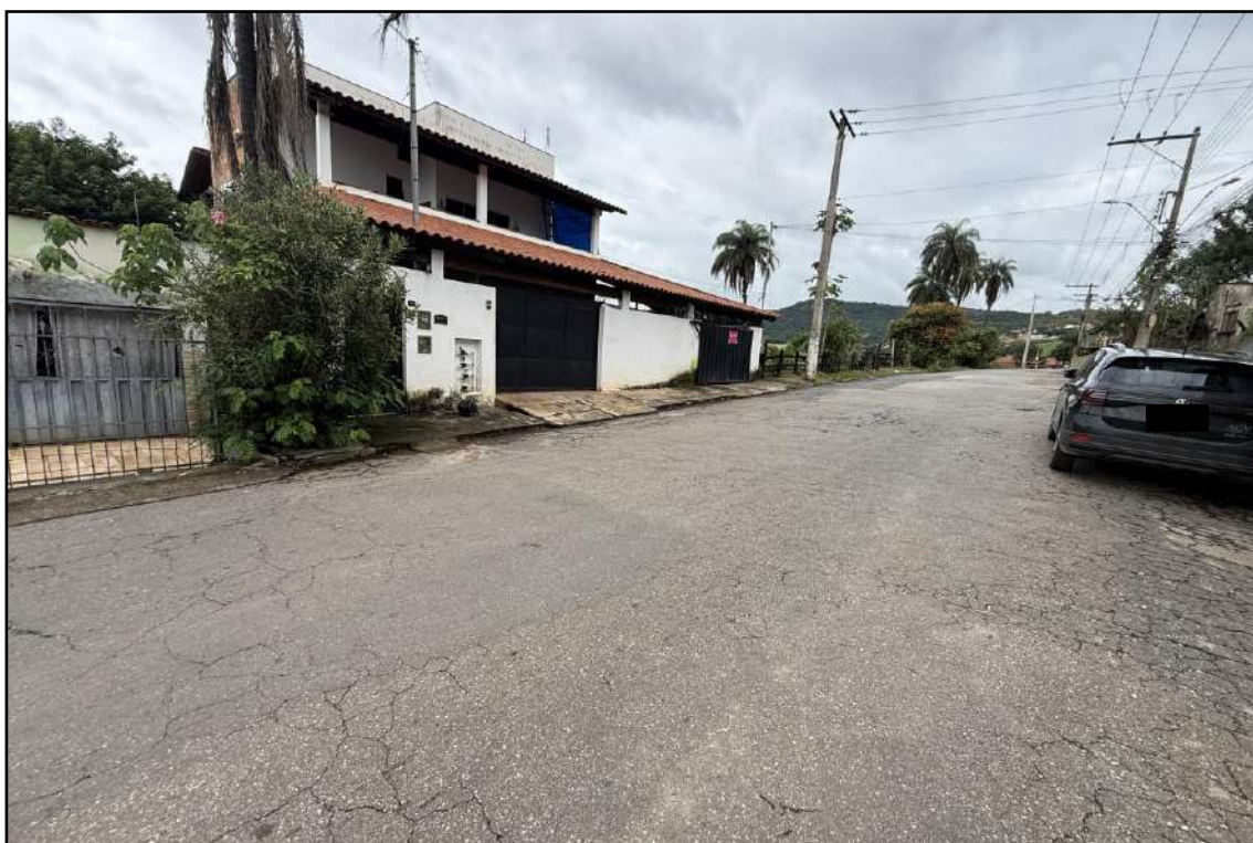
Figura 3 – Via de acesso ao imóvel objeto deste Laudo Pericial.
