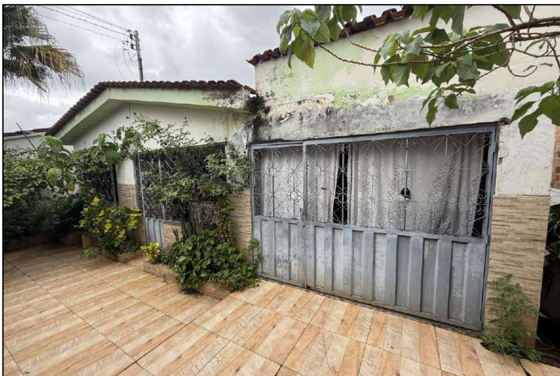
Figura 4 – Vista externa do imóvel objeto deste Laudo Pericial.
