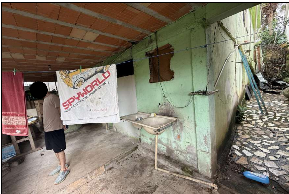
Figura 18 – Vista externa da “casa subsolo” objeto deste Laudo Pericial.
