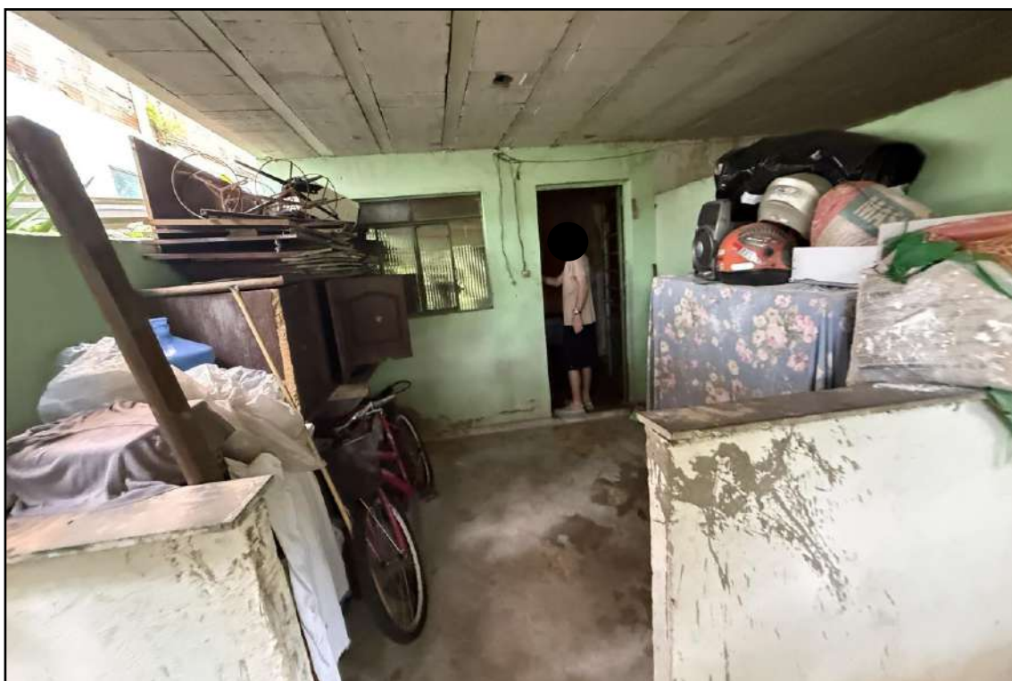
Figura 9 – Vista externa da “casa subsolo” objeto deste Laudo Pericial.
