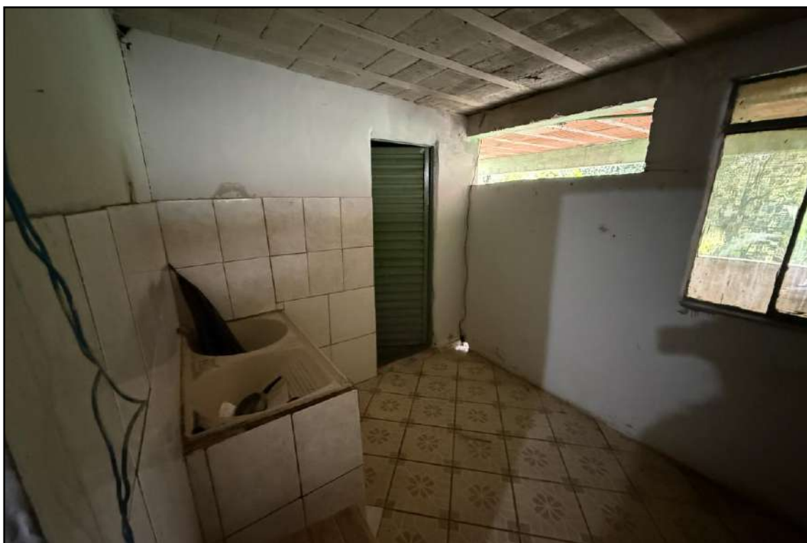
Figura 14 – Vista interna da “casa subsolo” objeto deste Laudo Pericial.
