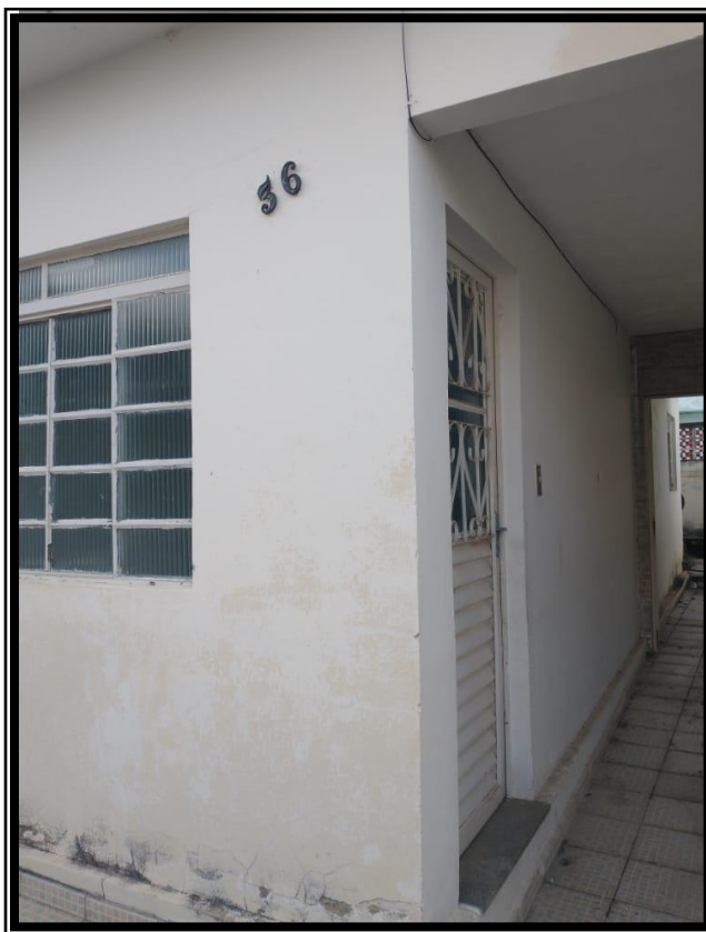
Detalhes da gargem coberta e porta de entrada
