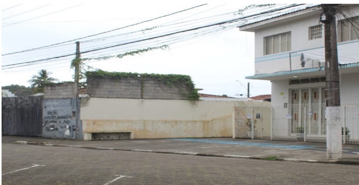
Foto 2 – Fachada Lateral Direita
