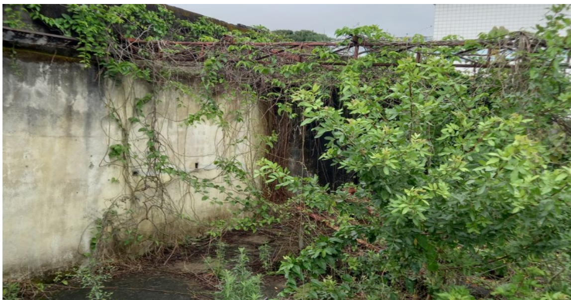
Foto 4 – Vista dos Fundos
