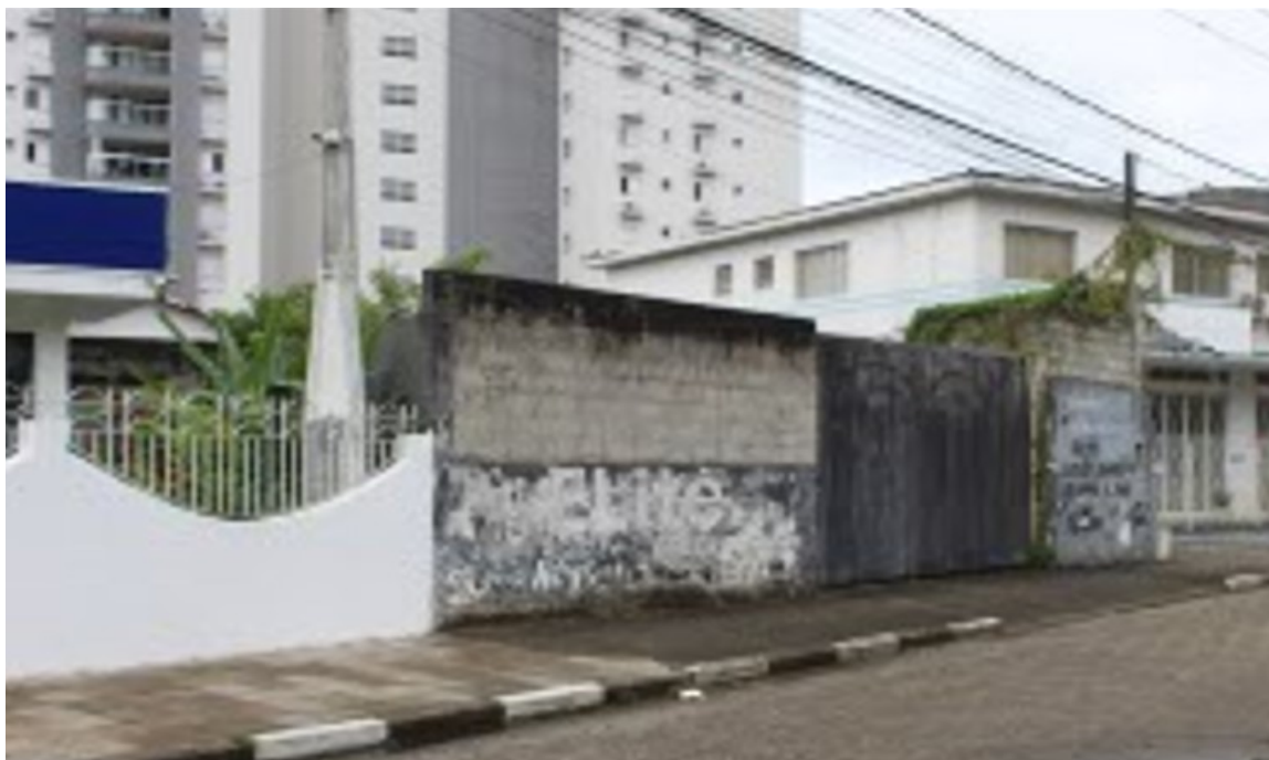
Foto 3 – Fachada Lateral Esquerda
