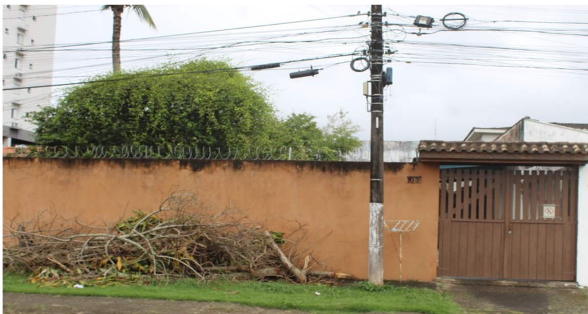
Foto 2 – Vista do Confrontante dos Fundos
