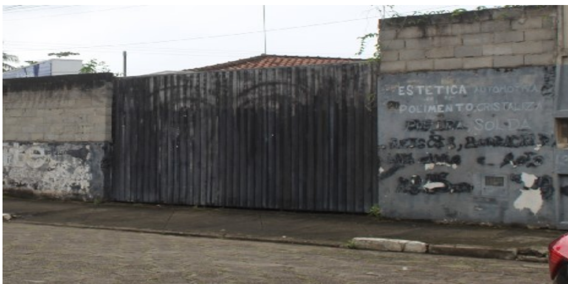
Foto 1 – Vista da Fachada
