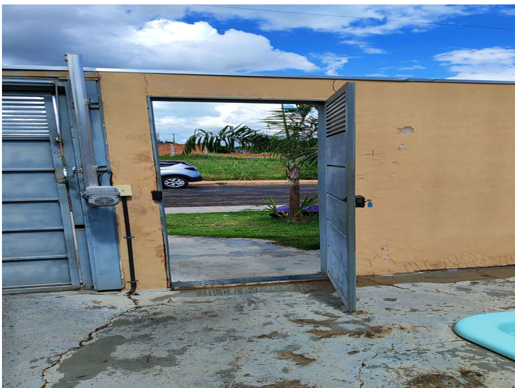
PARTE EXTERNA (PORTÃO PEDESTRES LATERAL).
