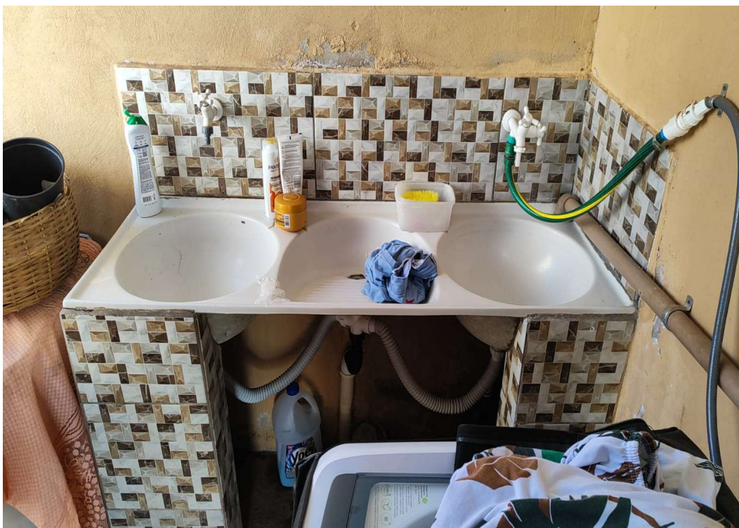
PARTE EXTERNA (LAVANDERIA).
