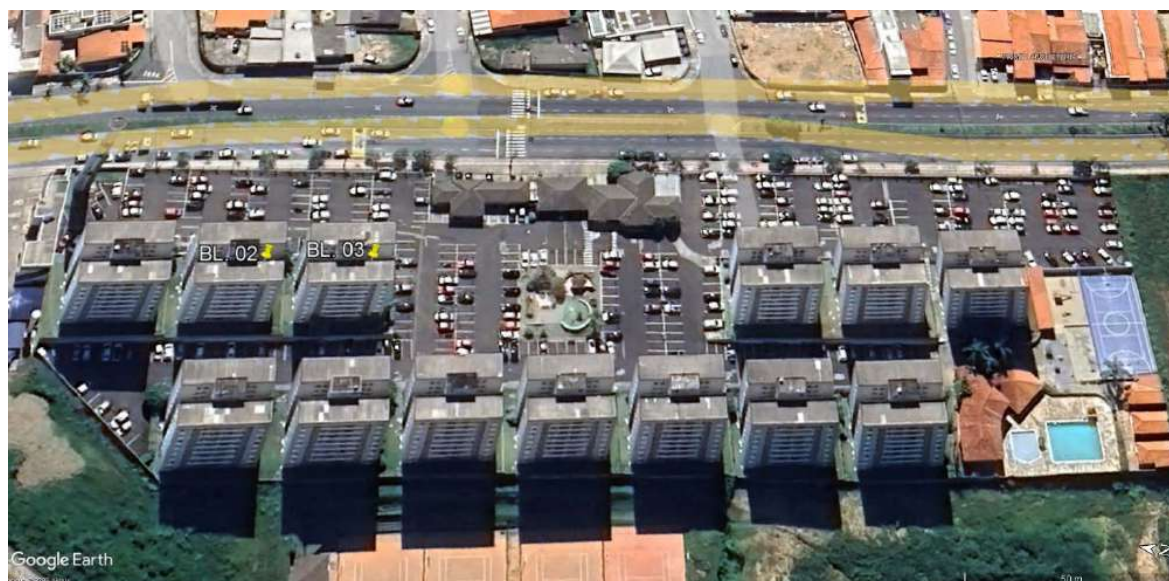
Vista geral do Condomínio.
