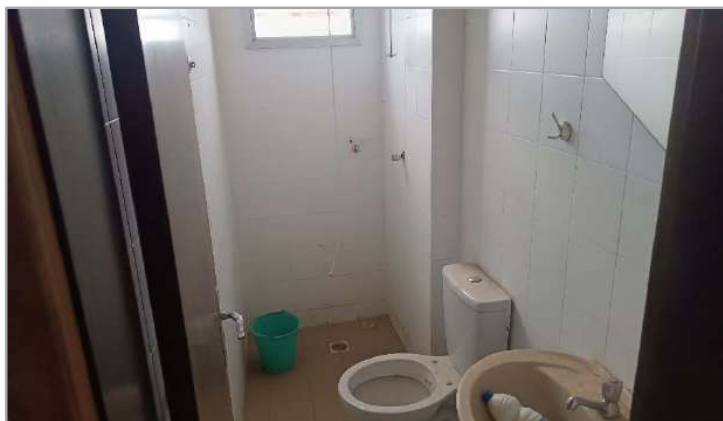
13. Mat. 7.809 -Ap. 703 - Banheiro.
