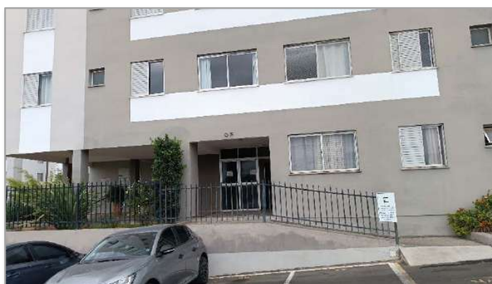
22. Mat. 94.159 - Acesso – bloco 03.
