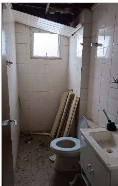
30. Mat. 94.159 - Ap. 501 - Banheiro.
