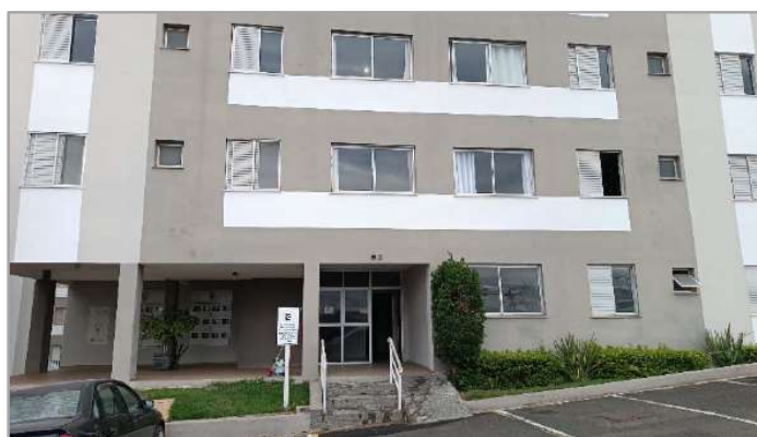
5. Mat. 7.809 -Acesso – bloco 02.
