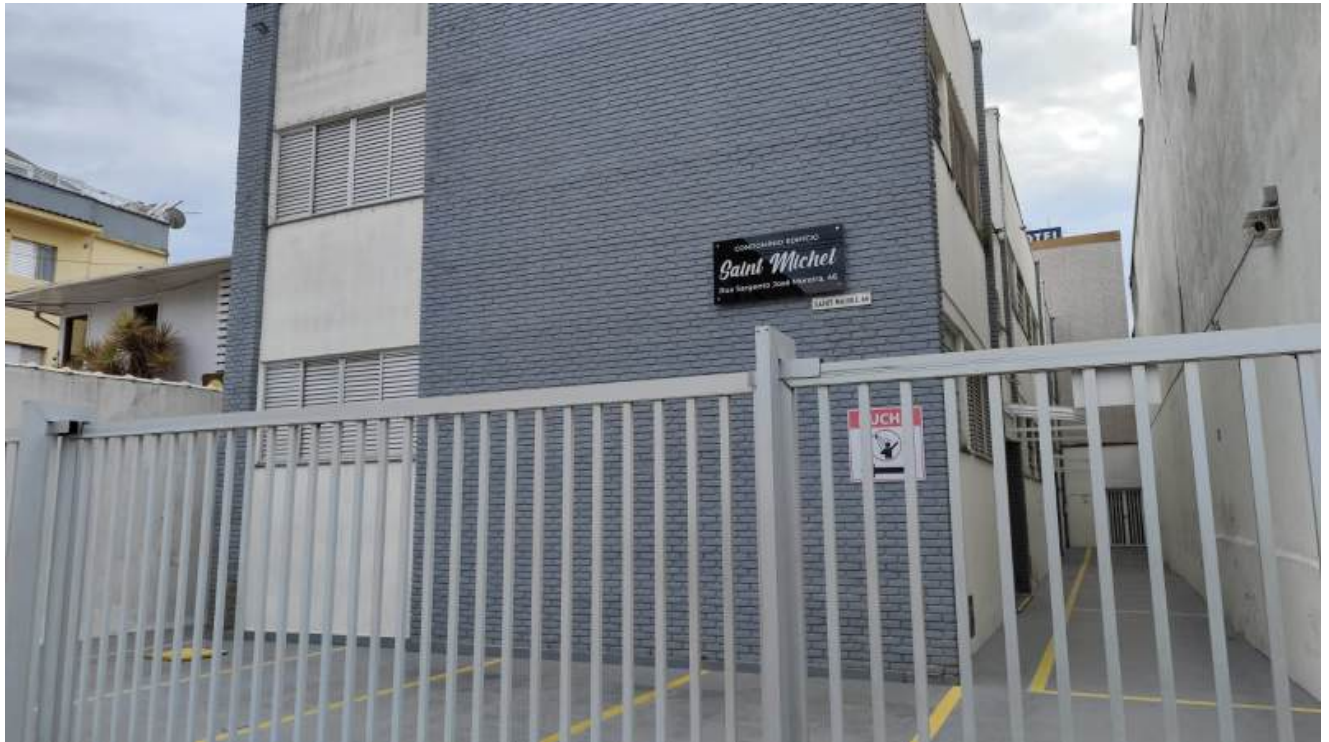
Fachada do prédio.
