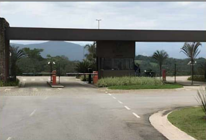
PORTARIA DO CONDOMÍNIO
