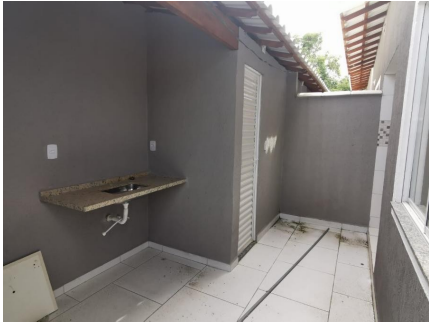
Representação Fundos Descrição BANHEIRO EXTERNO E BANCADA DE APOIO A CHURRASQUEIRA Data Foto 08/01/2020
