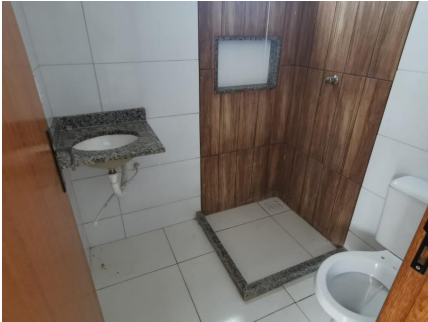
Representação Banheiro Social Descrição Data Foto 08/01/2020
