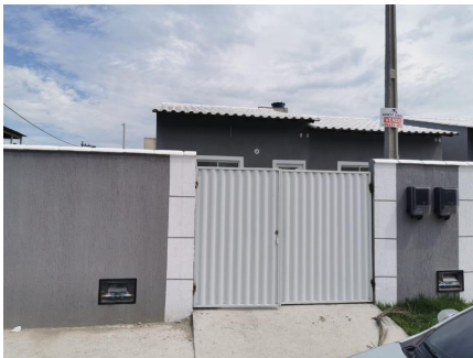
Representação Fachada Descrição CASA 05 Data Foto 08/01/2020
