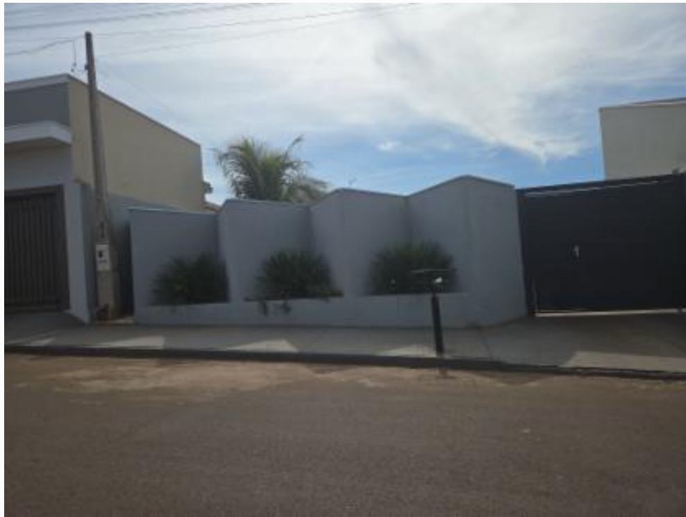
Fachada do vizinho esquerdo
