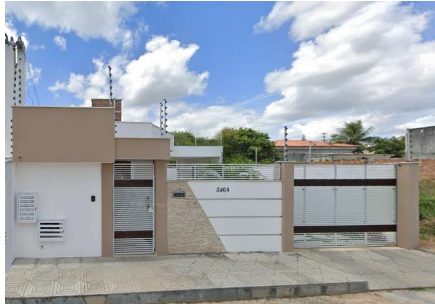
Representação Fachada Principal Descrição Data Foto 31/01/2024
