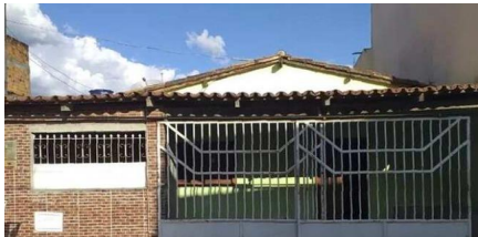
Representação Fachada Principal Descrição Data Foto 31/01/2024
