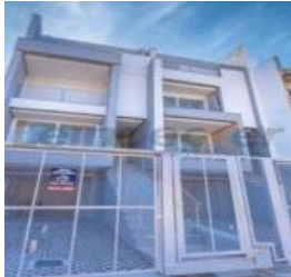
Representação Fachada Principal Descrição Data Foto 07/10/2021
