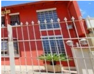
Representação Fachada Principal Descrição Data Foto 07/10/2021
