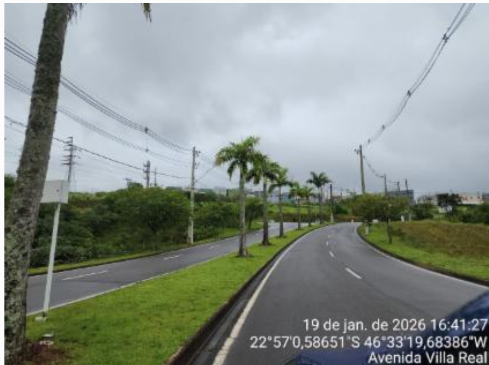
Rua de acesso
