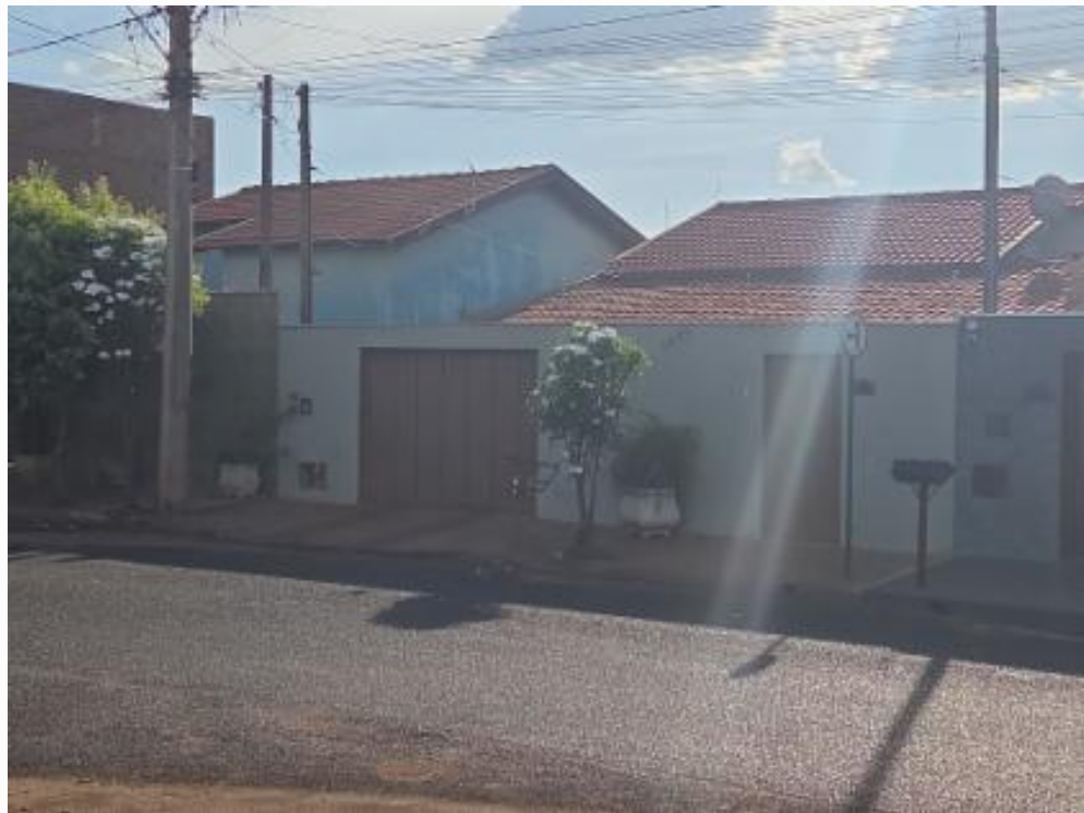
Fachada do vizinho esquerdo
