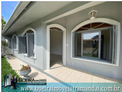
Representação Fachada Principal Descrição Data Foto
