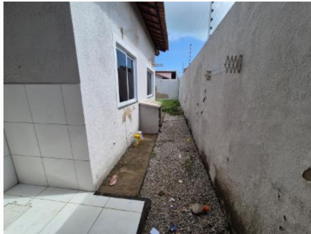
Circulação externa lateral e terraço
