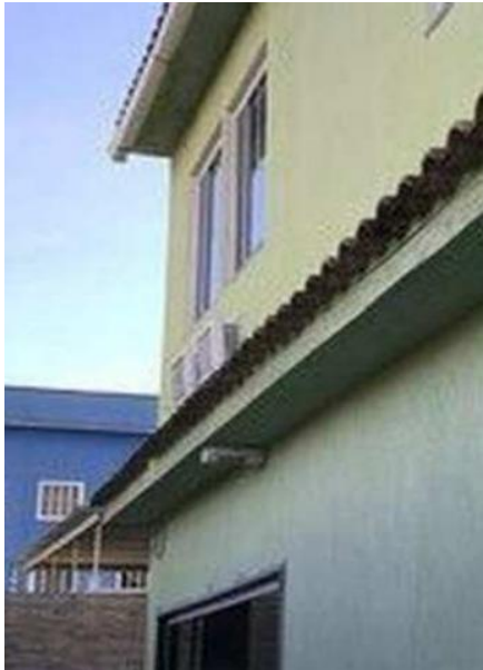
Representação Fachada Principal Descrição Data Foto 23/10/2023
