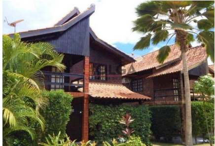
Representação Fachada Principal Descrição Data Foto 23/01/2024
