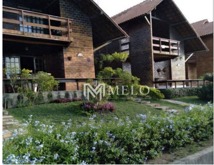
Representação Fachada Principal Descrição Data Foto 23/01/2024
