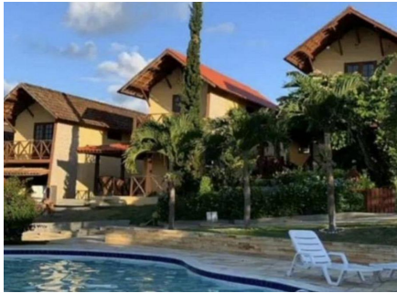
Representação Fachada Principal Descrição Data Foto 23/01/2024
