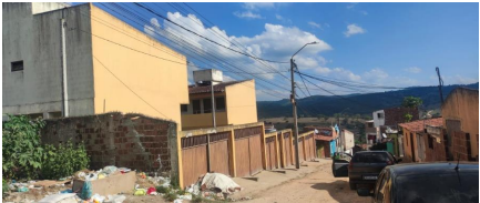
Representação Fachada Principal Descrição Data Foto 23/01/2024
