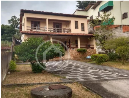
Representação Fachada Principal Descrição Data Foto 13/06/2024
