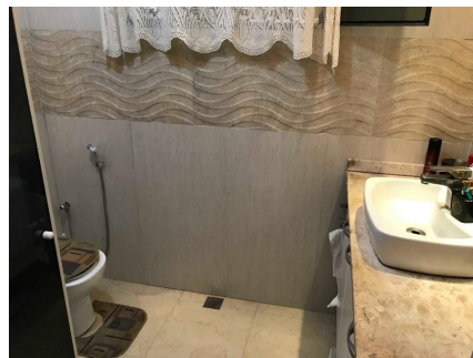
Representação Banheiro social Descrição 2 Data Foto 04/08/2021
