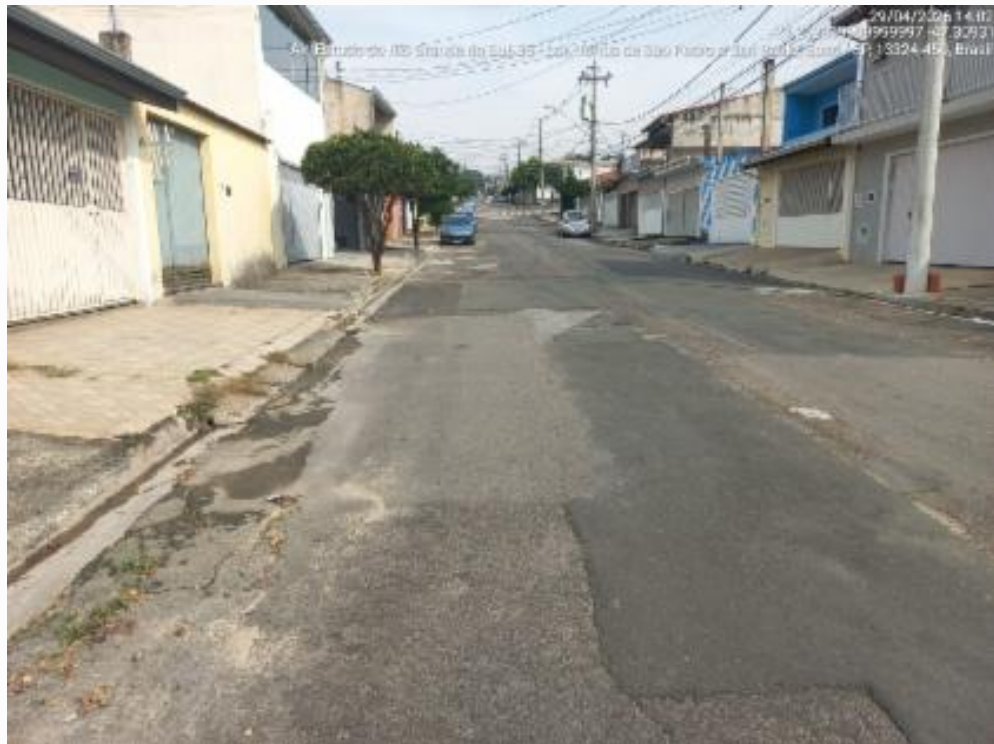
C_FOTO_02 VISTA RUA
