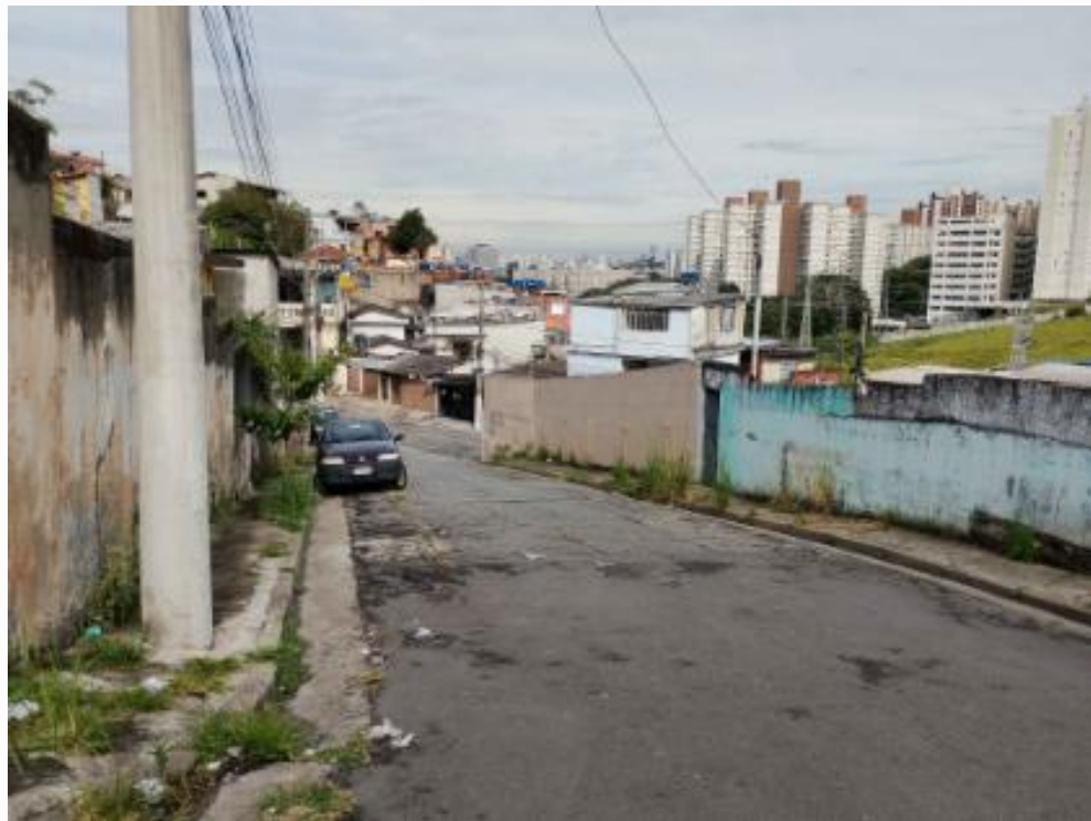
Vista rua acesso
