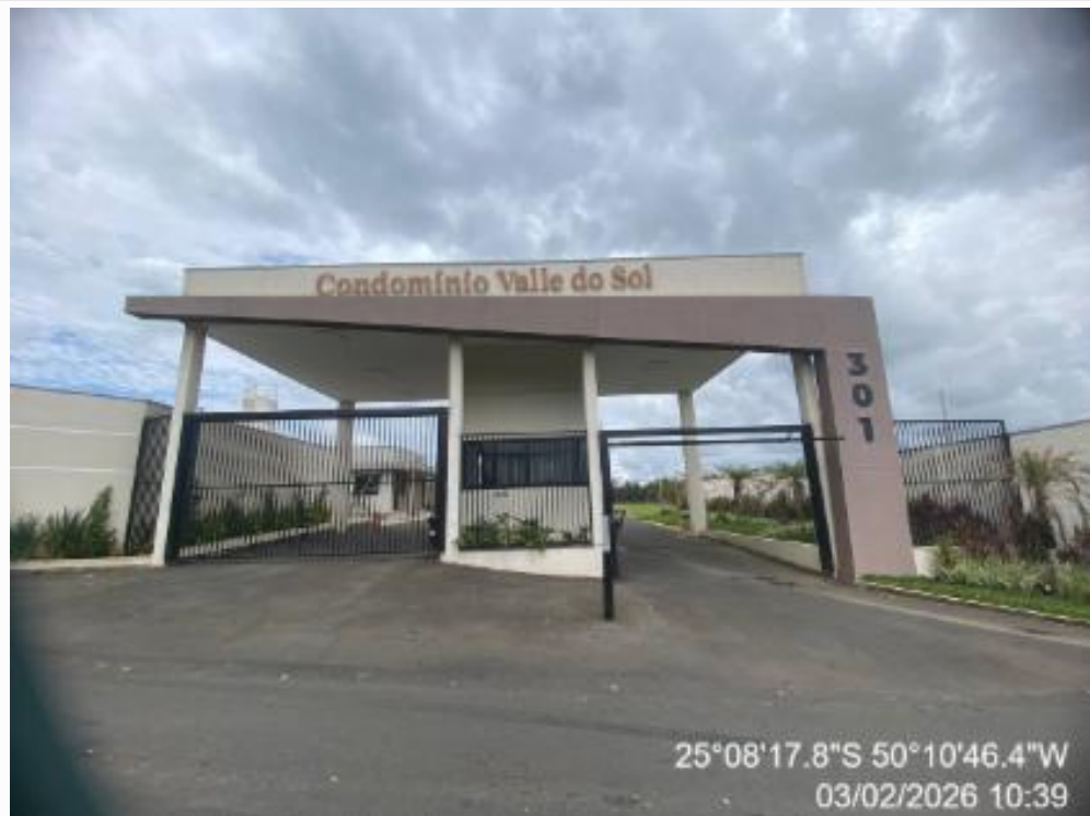
FACHADA DO CONDOMINIO
