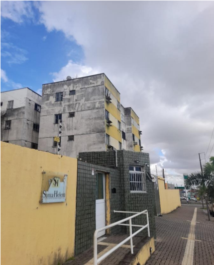
Representação Fachada Principal Descrição Data Foto 02/05/2025
