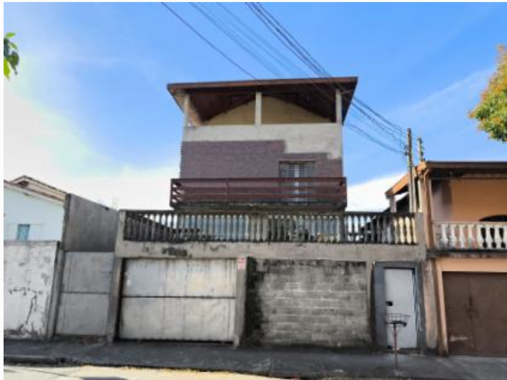
Fachada da casa
