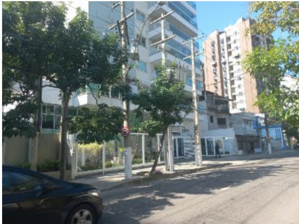
Fachada do condomínio, vista 01
