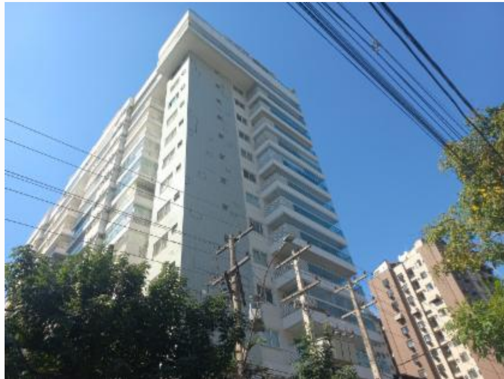
Fachada do condomínio, vista 02
