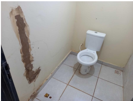
Representação Banheiro social Descrição Data Foto 12/07/2021
