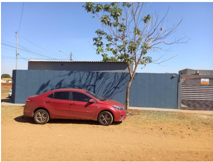
Representação Fachada Principal Descrição Data Foto 12/07/2021
