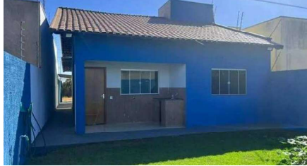
Representação Fachada Principal Descrição Fachada Data Foto 11/01/2024
