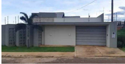
Representação Fachada Principal Descrição Fachada Data Foto 11/01/2024
