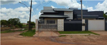
Representação Fachada Principal Descrição Fachada Data Foto 08/01/2024
