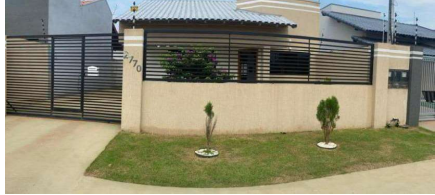
Representação Fachada Principal Descrição Fachada Data Foto 11/01/2024
