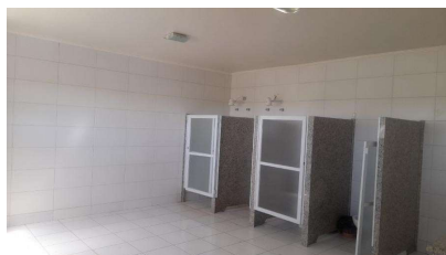
Representação Banheiro social Descrição 2 Data Foto 22/03/2022
