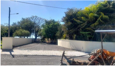
Representação Fachada Principal Descrição Data Foto 22/03/2022
