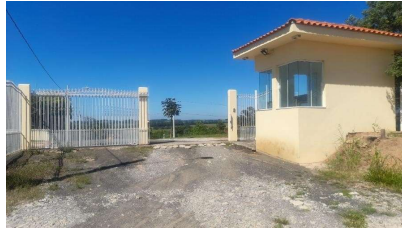
Representação Fachada Principal Descrição Data Foto 22/03/2022
