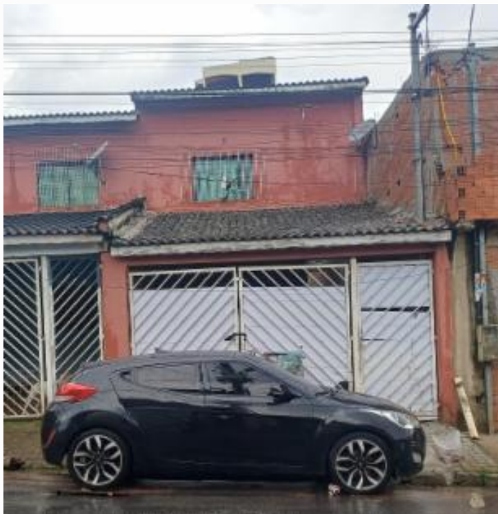
vista parcial da fachada
