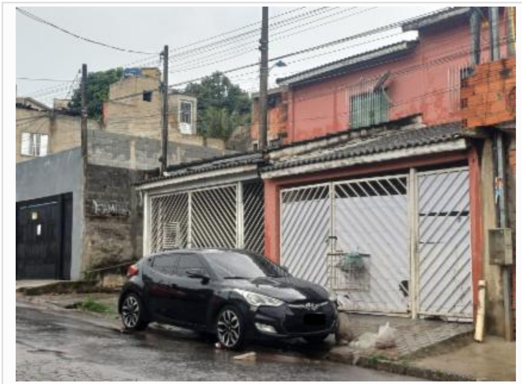
vista parcial da fachada
