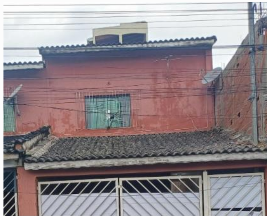
vista parcial da fachada
