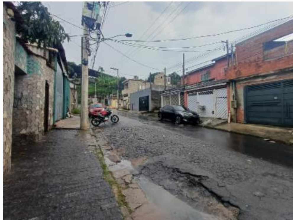
vista parcial da fachada - rua
