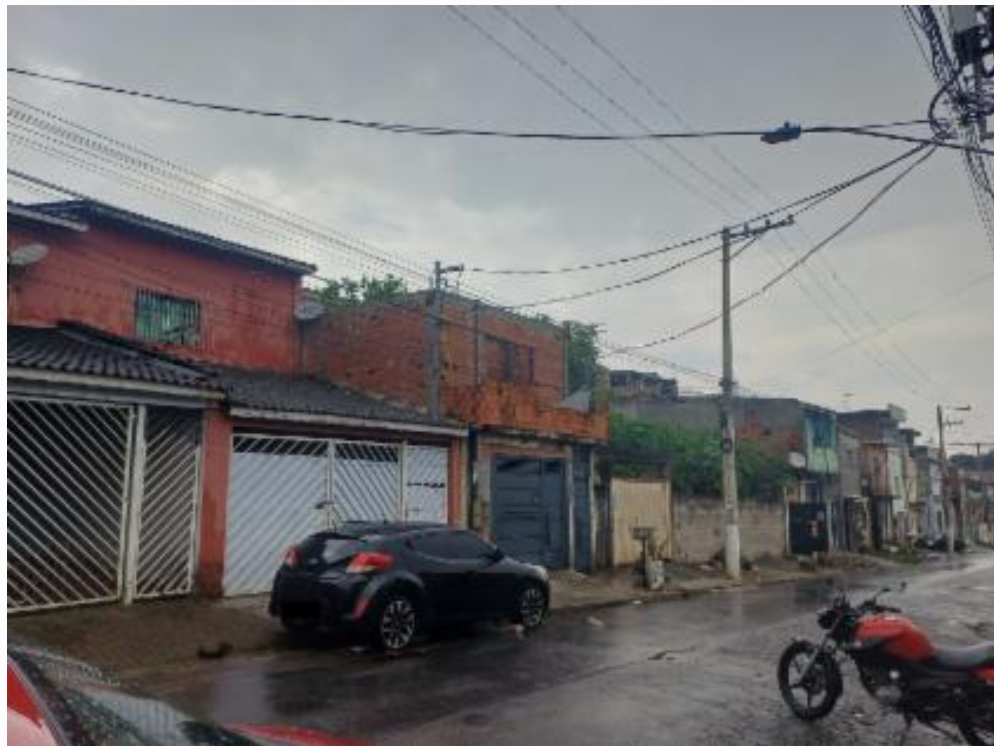
vista parcial da fachada - rua
