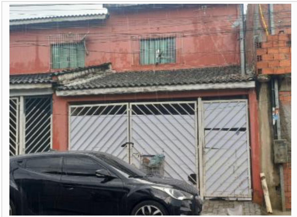
vista parcial da fachada
