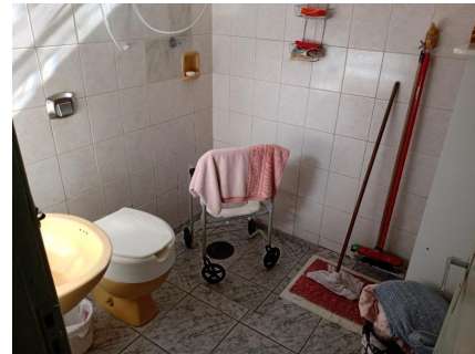
Representação Banheiro Suíte Descrição Data Foto 06/08/2021
