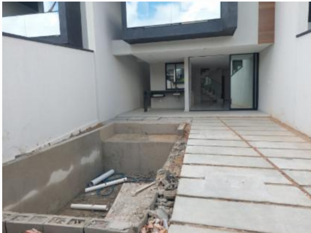
Piscina (em construção)
