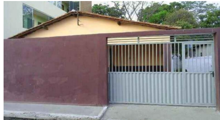
Representação Fachada Principal Descrição Fachada Data Foto 16/11/2022
