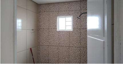
Representação Banheiro Descrição Banheiro Data Foto 11/11/2022
