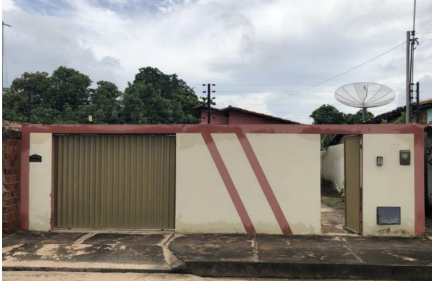
Representação Fachada Principal Descrição Fachada Data Foto 16/11/2022
