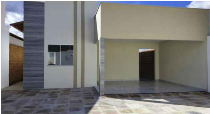
Representação Fachada Principal Descrição Fachada Data Foto 16/11/2022
