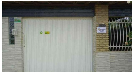
Representação Fachada Principal Descrição Fachada Data Foto 16/11/2022
