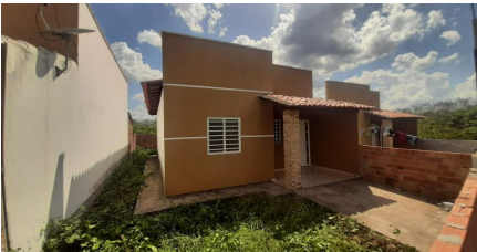
Representação Fachada Principal Descrição Fachada Data Foto 11/11/2022
