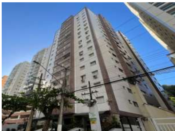
Vista parcial do edifício
