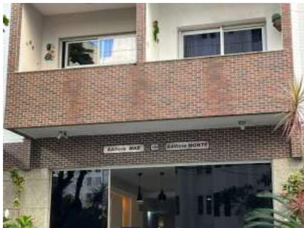
Vista parcial do edifício
