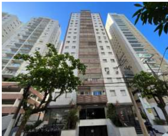
Vista parcial do edifício
