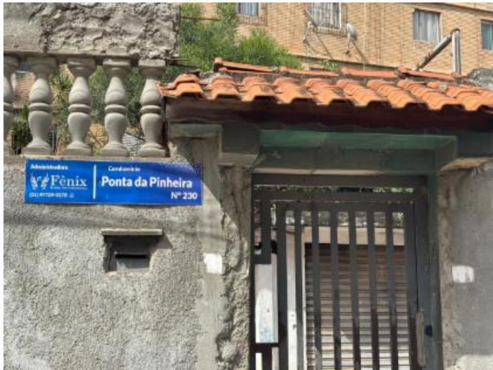
Fachada condomínio frontal ID
