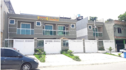
Representação Fachada Descrição Data Foto 25/10/2019
