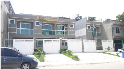
Representação Fachada Descrição Data Foto 25/10/2019
