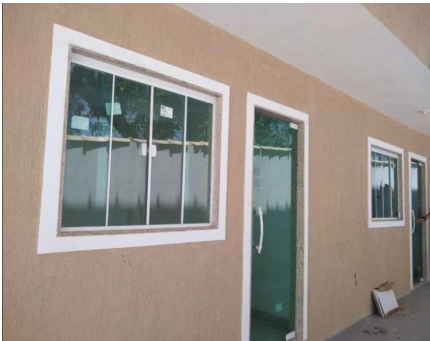
Representação Fachada Descrição Data Foto 25/10/2019
