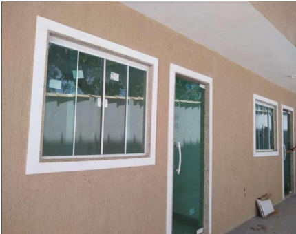
Representação Fachada Descrição Data Foto 25/10/2019
