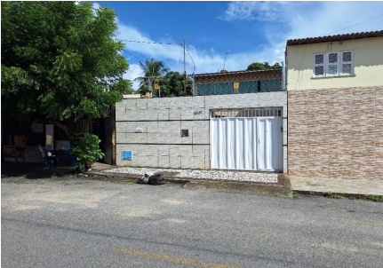
Representação Fachada Principal Descrição Data Foto
