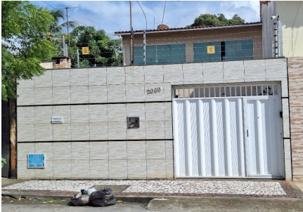
Representação Fachada Principal Descrição Data Foto
