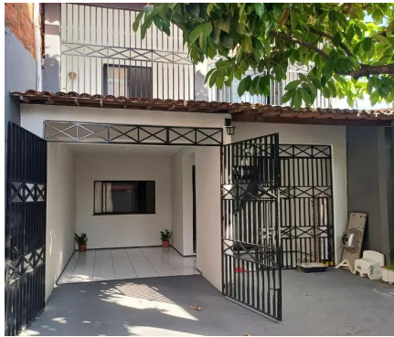
Representação Fachada Principal Descrição Data Foto
