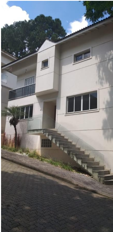
Representação Fachada Descrição Interna Data Foto 13/03/2020
