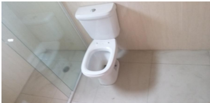
Representação Banheiro Suíte Descrição Data Foto 28/02/2020
