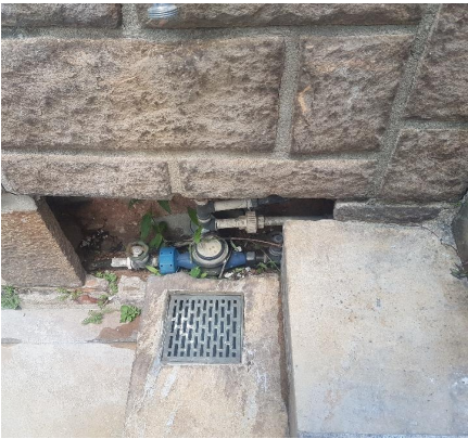
Representação Vista da Rua Descrição Data Foto 26/01/2023
