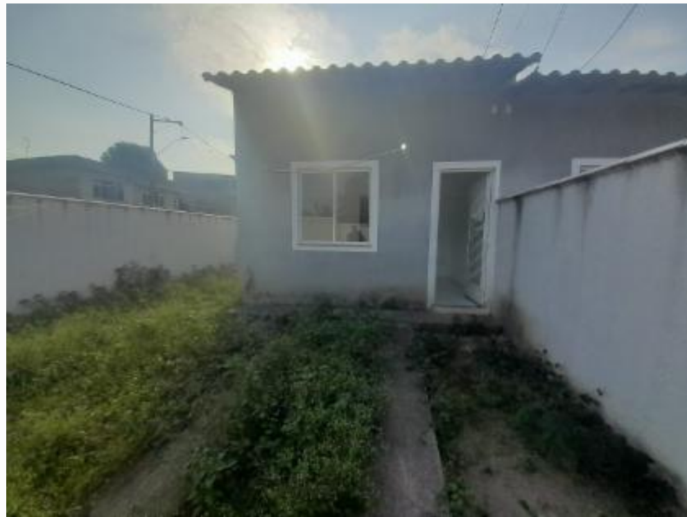
vista interna fachada
