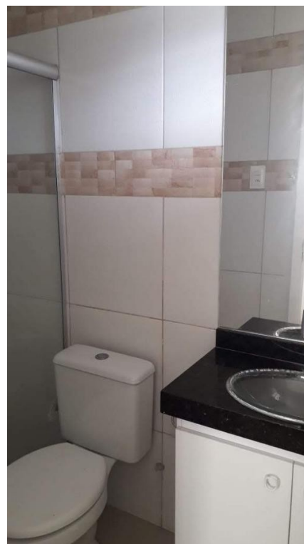
Representação Banheiro Suite Descrição Suite 02 Data Foto 13/05/2020
