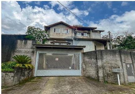
Representação Fachada Principal Descrição AMOSTRA 3 Data Foto 19/01/2024
