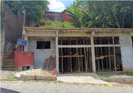
Representação Fachada Principal Descrição AVALIANDO Data Foto 19/01/2024
