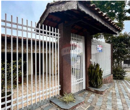
Representação Fachada Principal Descrição AMOSTRA 2 Data Foto 19/01/2024
