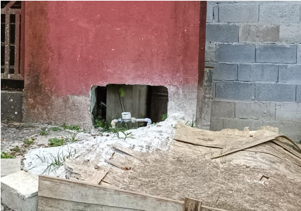
Representação Fachada Principal Descrição CAVALETE DE ÁGUA Data Foto 19/01/2024
