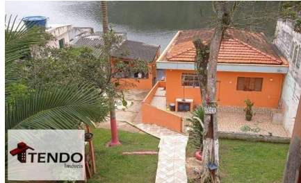
Representação Fachada Principal Descrição AMOSTRA 1 Data Foto 19/01/2024
