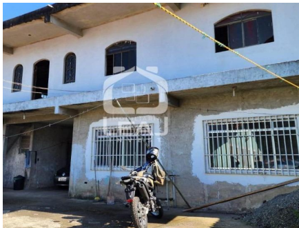
Representação Fachada Principal Descrição AMOSTRA 4 Data Foto 19/01/2024
