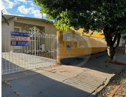
Representação Fachada Principal Descrição Data Foto 17/06/2024
