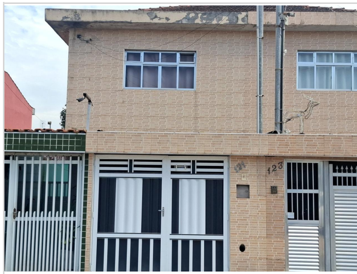
Fachada do avaliando
