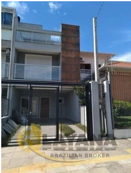
Representação Fachada Principal Descrição Data Foto
