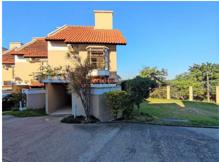
Representação Fachada Principal Descrição Data Foto
