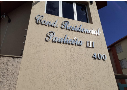
Representação Fachada Principal Descrição Data Foto 29/11/2022
