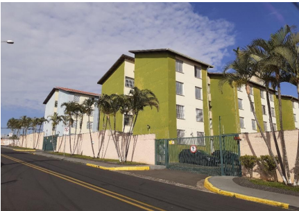
Representação Fachada Principal Descrição Data Foto 29/11/2022
