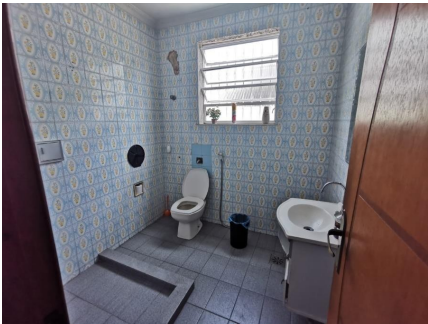
Representação Banheiro Social Descrição Data Foto 04/02/2020
