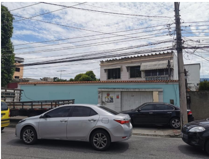
Representação Fachada Descrição Data Foto 04/02/2020
