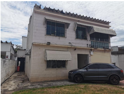
Representação Fachada Descrição Data Foto 04/02/2020
