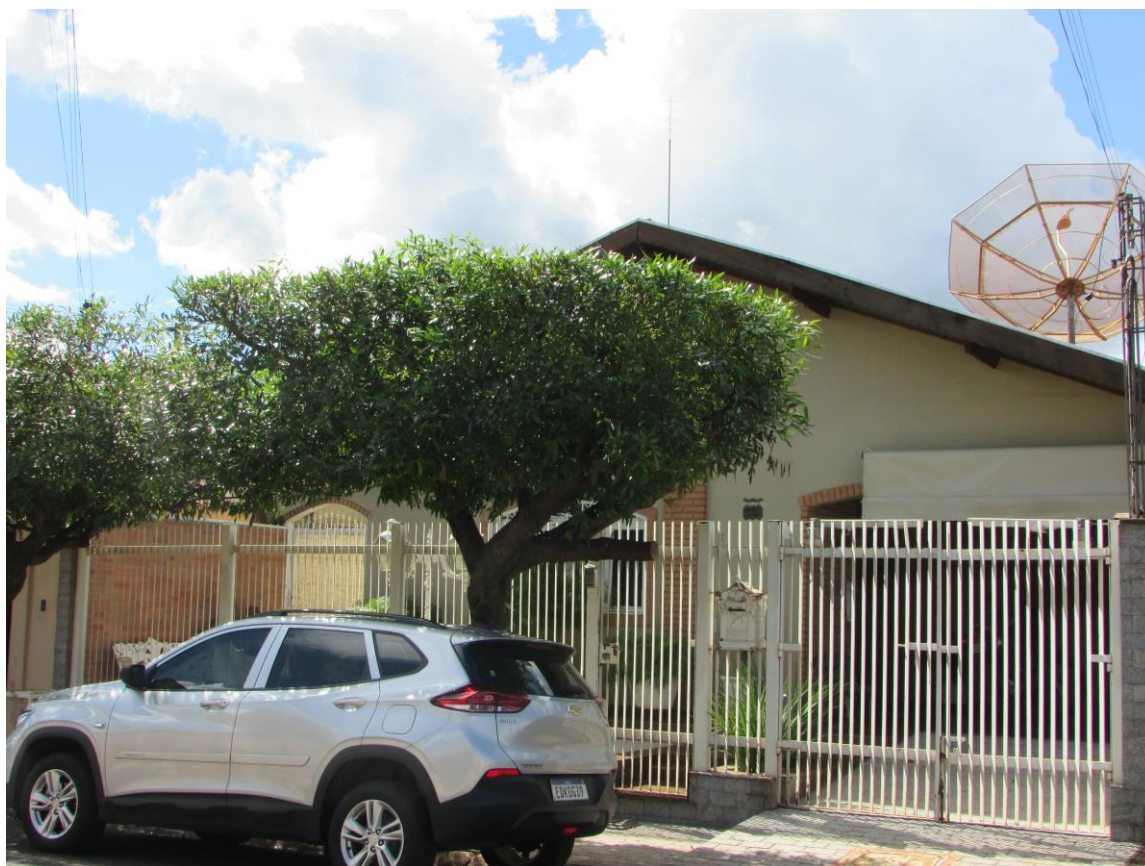
Vista da face frontal do imóvel voltada para a Avenida 47.
