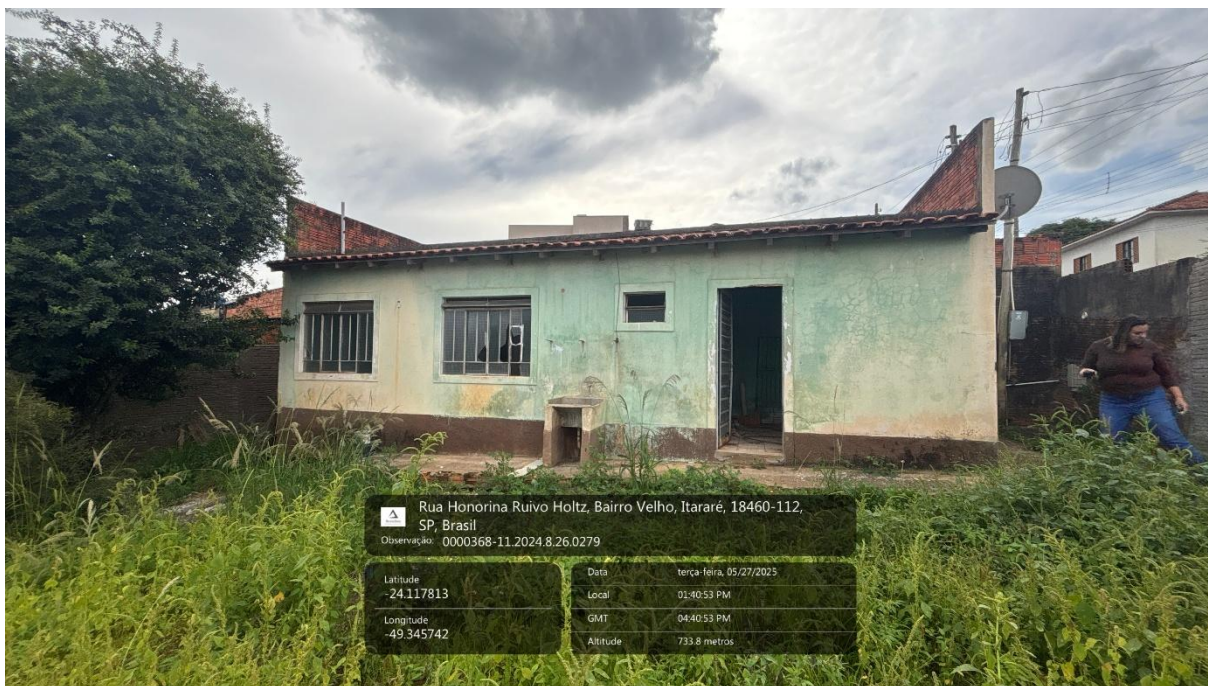
Imagem 1: Fachada da edificação.
