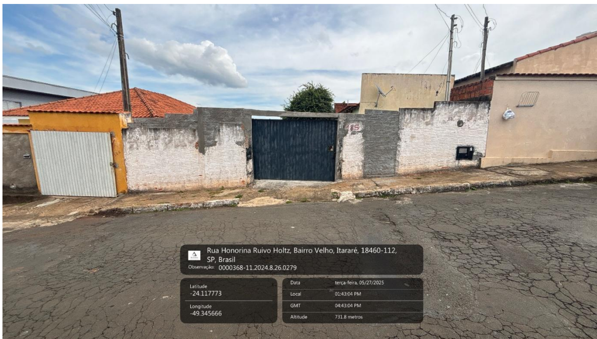
Imagem 3: Fachada do imóvel.
