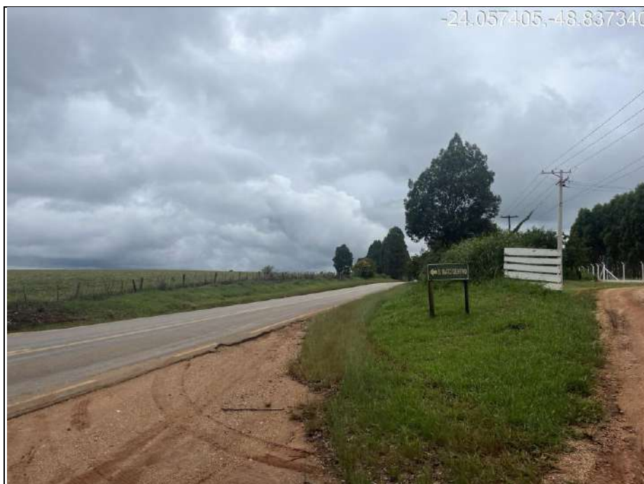
Imagem 2: Vista para a rodovia
