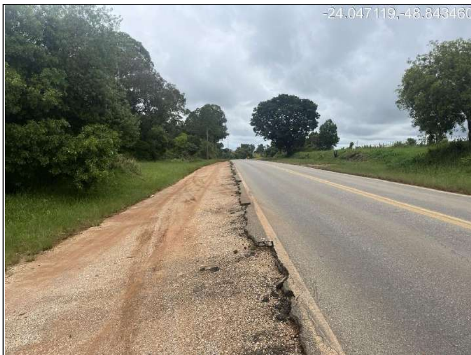
Imagem 3: Vista para a rodovia
