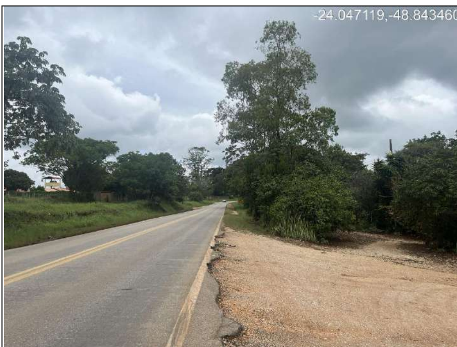
Imagem 2: Vista para a rodovia
