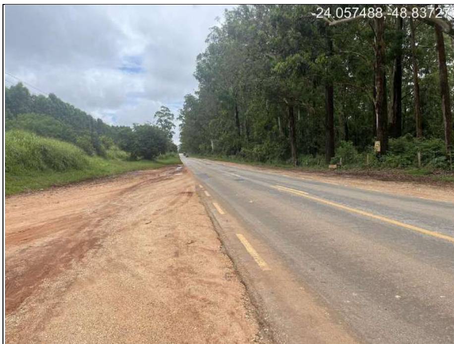
Imagem 3: Vista para a rodovia
