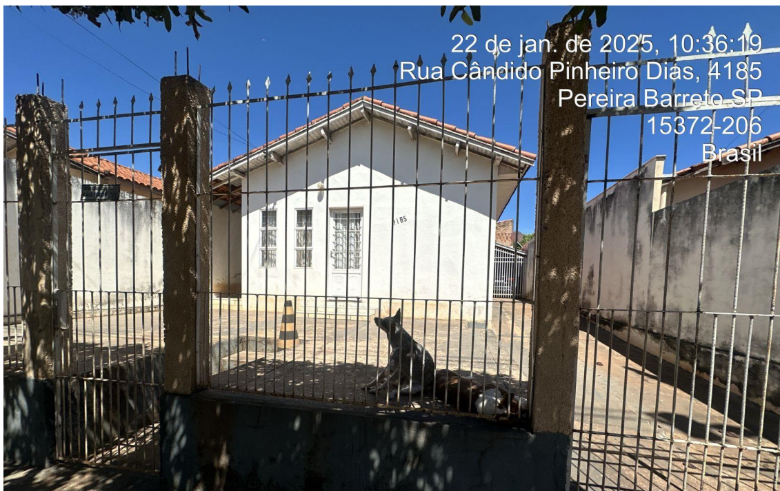
Imagem 02: Fachada do imóvel.
